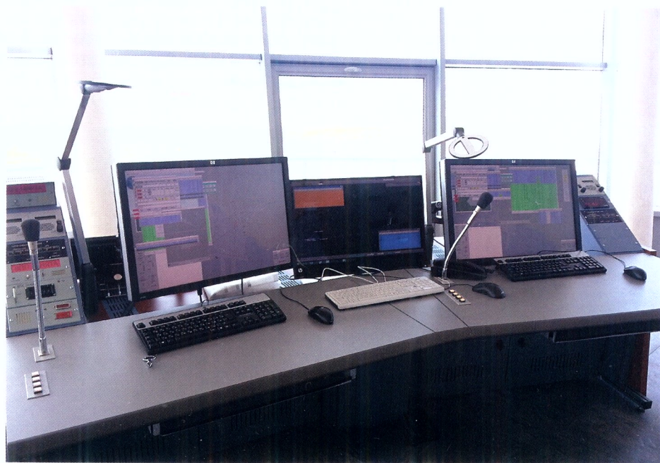
Выносная консоль управления и отображения информации, установленная на рабочем месте диспетчера
