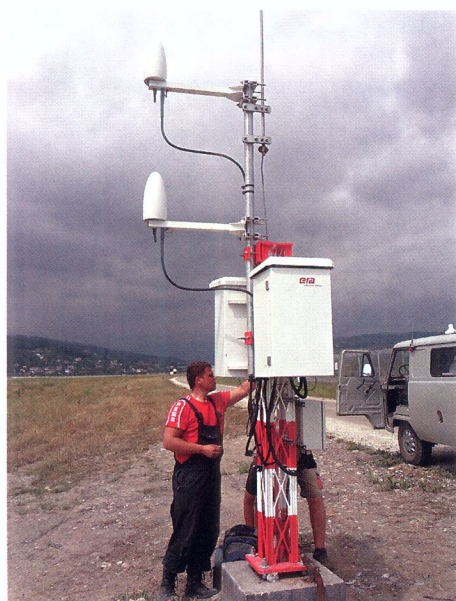
Монтаж и пуско-наладочные работы приемной и передающей станций на ВПП 2 а/п Сочи (Адлер)
