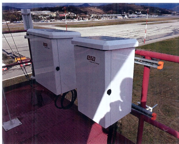
Оборудование приемной и передающей станций на крыше нового КДП а/п Сочи.
