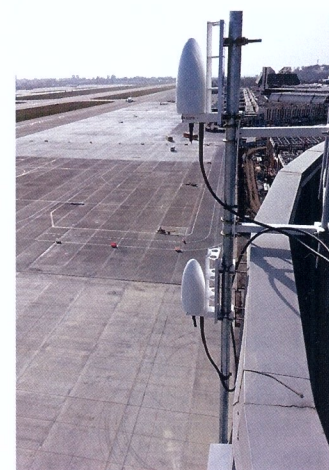
Оборудование приемной и передающей станций на крыше нового КДП а/п Сочи.
