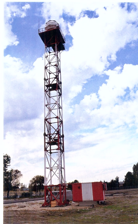
РЛС ОЛП-1 и ОЛП-2 «Атлантика» в аэропорту Сочи (Адлер)
