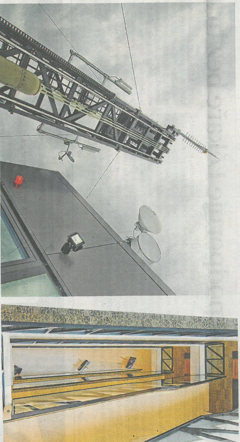
Společnost ERA Dominantou její nové budovy v Černé za Bory je stožár s výřahem pro umístění testovacích antén. Foto: Michal Klíma
